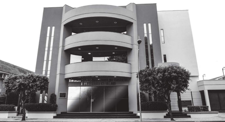
Sede concluída, inauguração ocorreu em 2001
