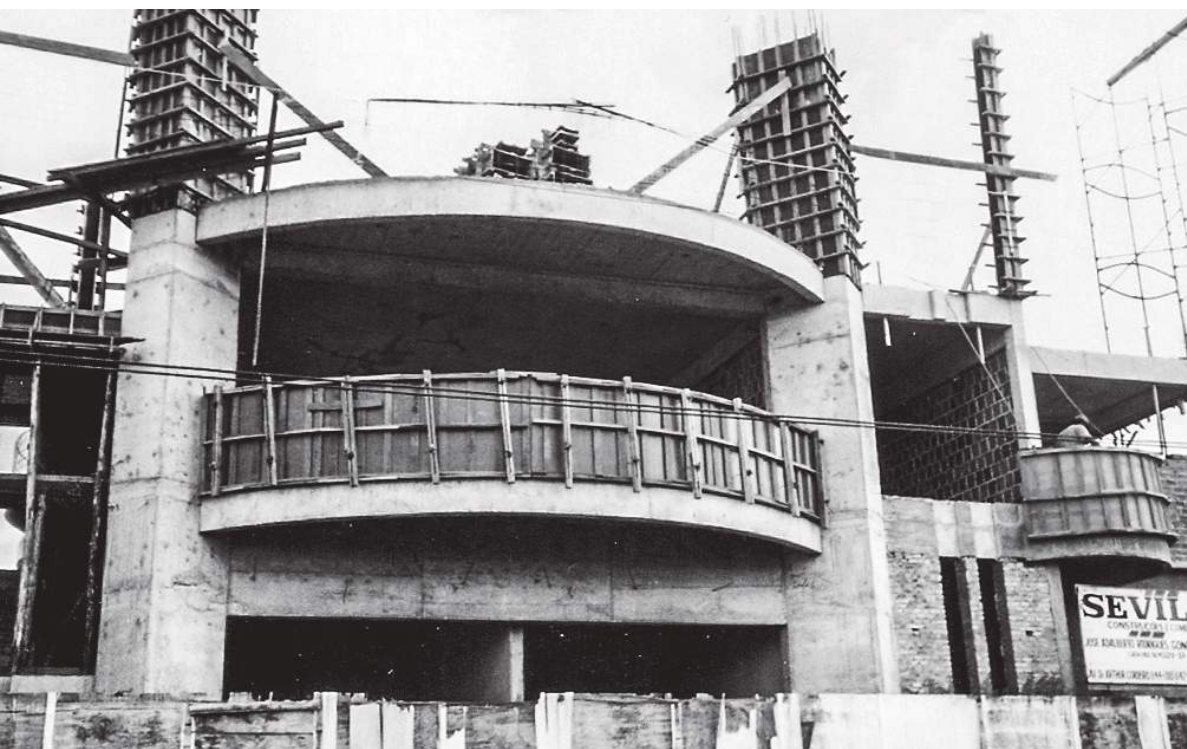
Atual sede do Sinbi na fase de construção
