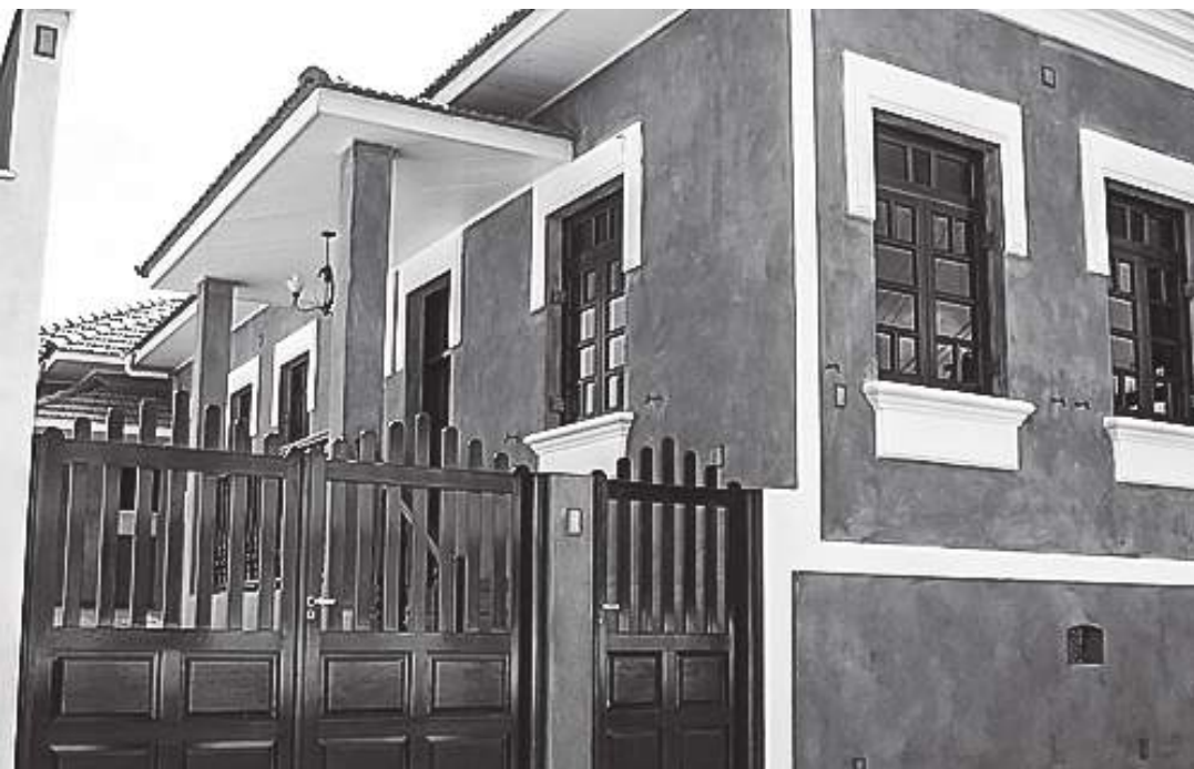
Sede do Instituto Pró-Criança após restauração de antigo imóvel
