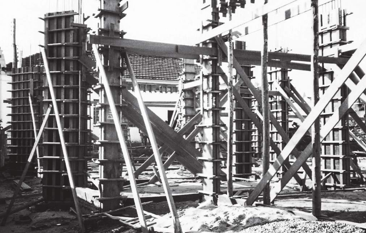
Início da construção da sede do Sinbi
